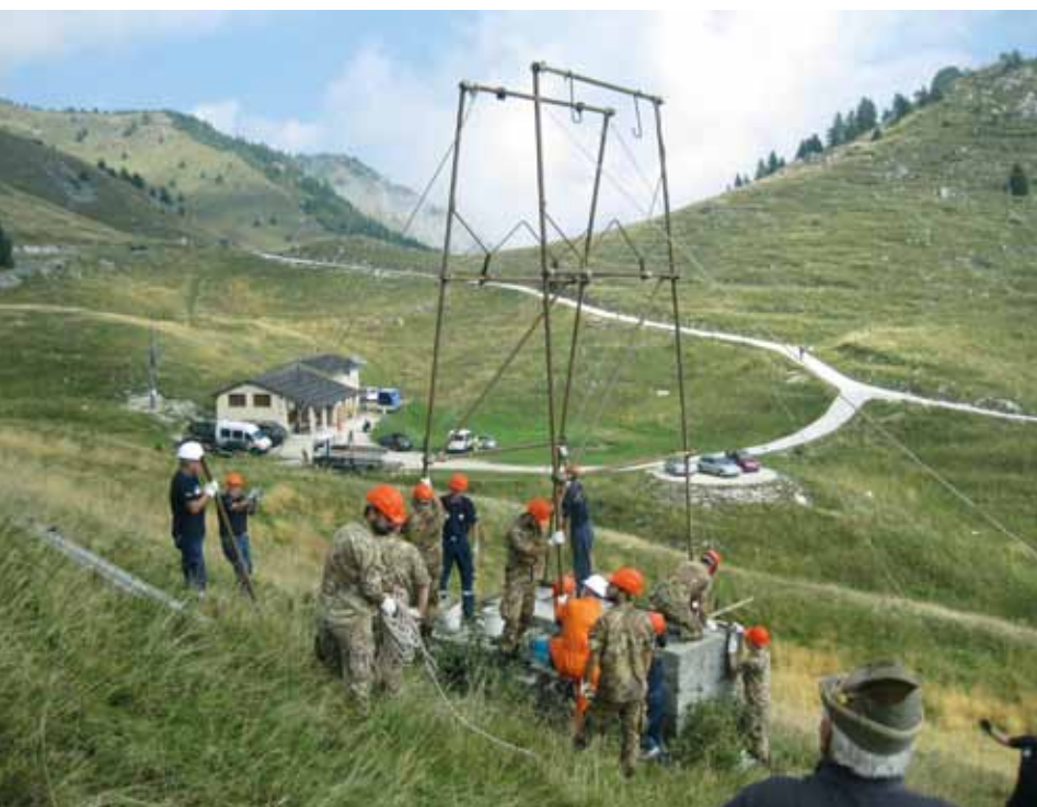
Volontari Ana e guastatori alpini del 2° reggimento sistemano una teleferica a malga Ardosetta.
